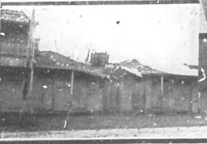
ELIA.—Los efectos del ciclón también se dejaron sentir en aquella localidad. La foto muestra un mástil de viento, derrumbado por la furia del huracán, sobre el techo de una de las casas.
